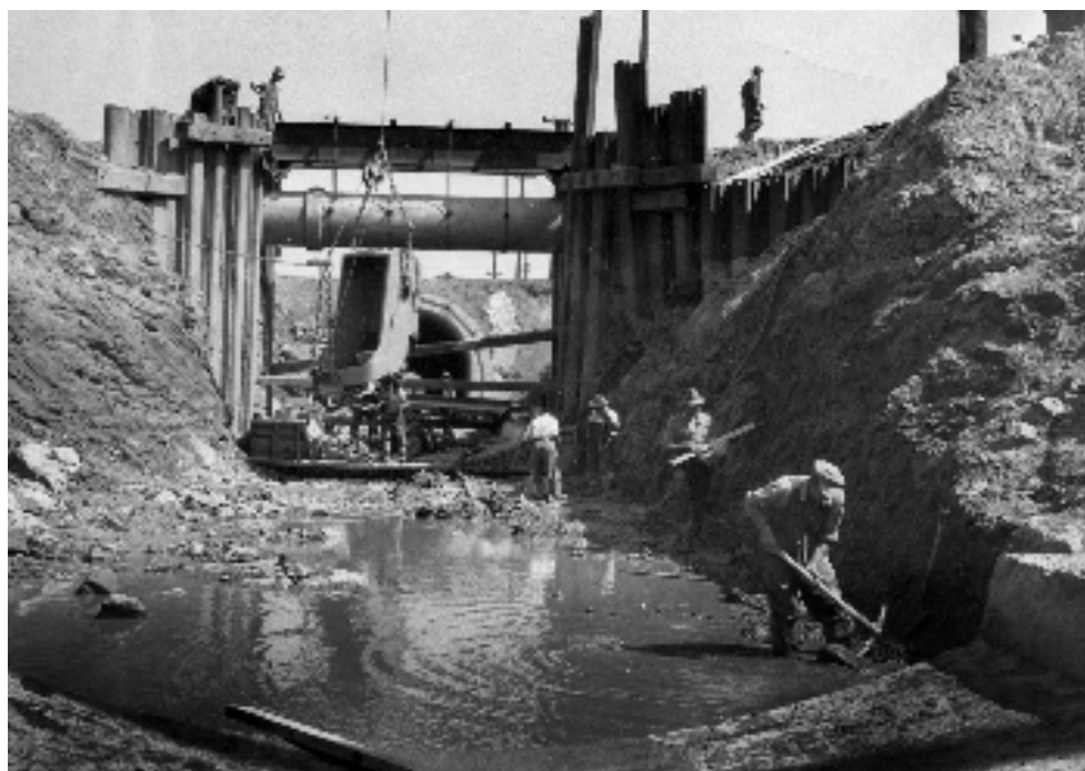
Canalisation du ruisseau Raimbault, quartier Notre-Dame-des-Neiges, 1961. Source: Archives de la Ville de Montréal
