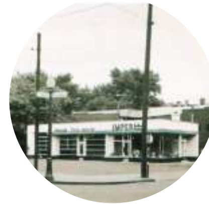
Photo de la station-service gérée par Armand Ferland durant les années 50.
